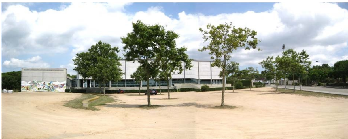
Pàrquing actual de vehicles del pavelló esportiu
