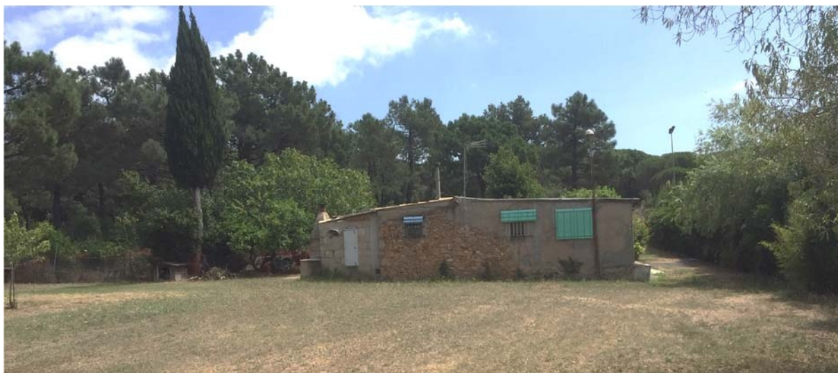
Construcció existent dins la parcel·la
